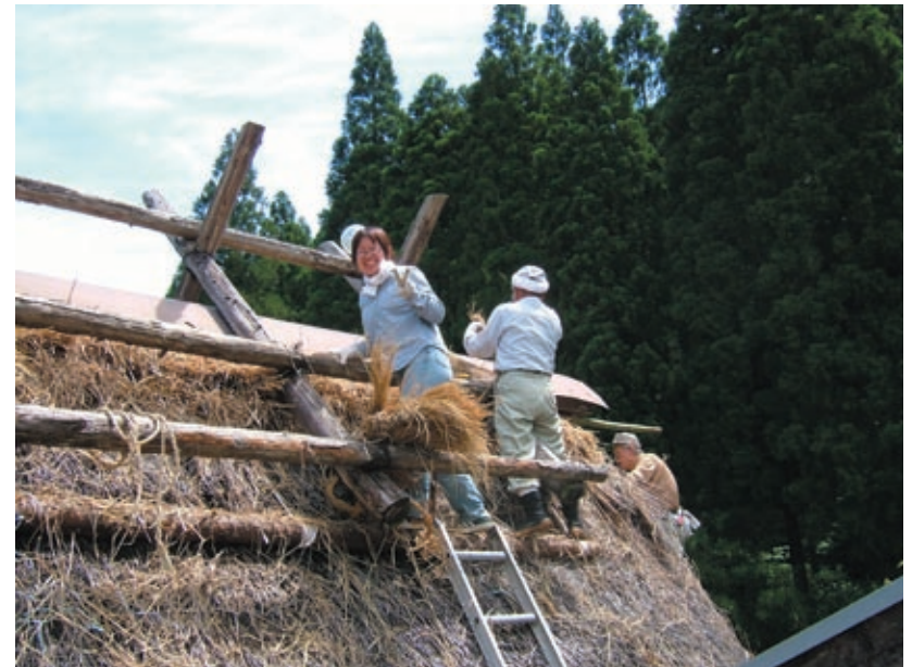
지붕 덮개를 바꾸는 작업에 참가한 젊은이 (오오이타현 분고오오노시)
