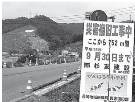
今なお、村のあちこちで復旧工事が行われている
